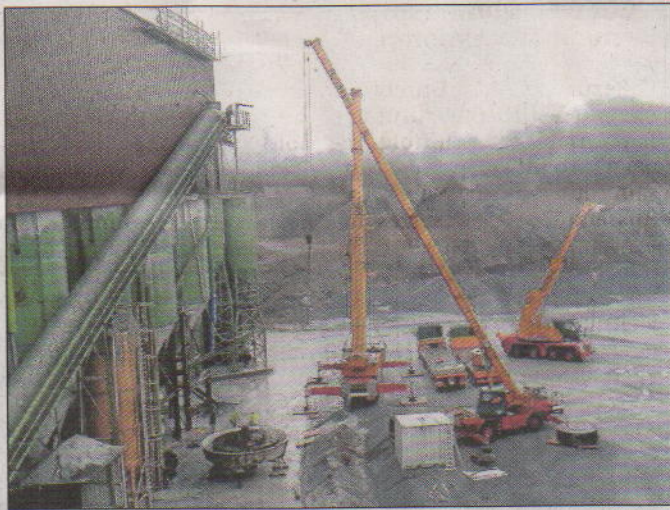
Ein 55 Meter hoher 200-Tonnen-Kran transportierte die neuen Bauteile, die bis zu 14 Tonnen Gewicht haben, direkt zum Sichter.
