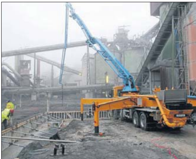
Im Westkalk-Steinbruch wurde mit den Arbeiten am neuen Steinbrecher begonnen.
