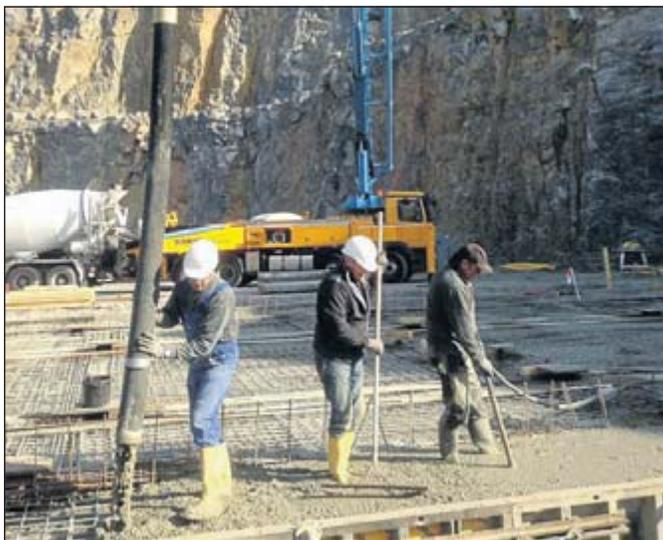
500 Kubikmeter Beton sind in den 600 Quadratmeter großen Untergrund der Edelsplittanlage im Steinbruch geflossen.
