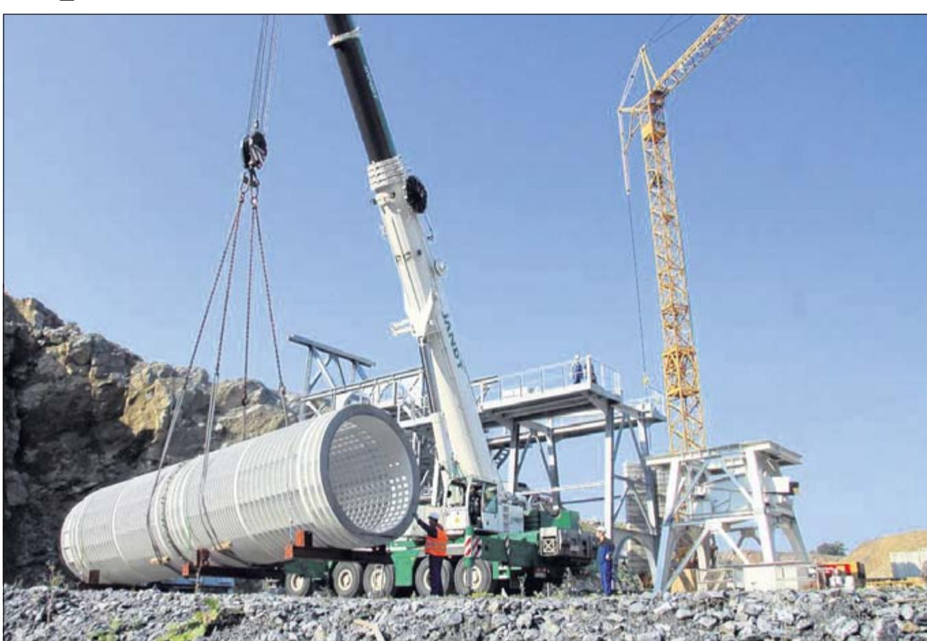
Was wie ein riesiger Lockenwickler aussieht, ist die neue 48 Tonnen schwere Siebtrommel. Sie soll ab kommendem Frühjahr das Gestein vom Lehm trennen, bevor der Kalk in den Brecher wandert. Die Kombination gilt als technisches Neuland. ■ Fotos: Lüke
