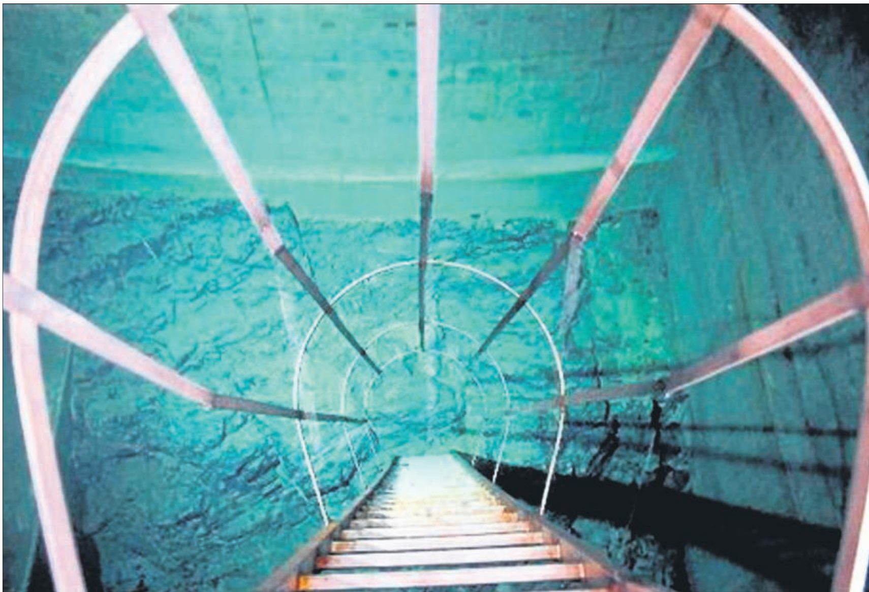
Die Hillenbergquelle II trägt die Hauptlast der Wasserversorgung für Warstein. Mit der Gerichtsentscheidung entfällt die Grundlage für die weitere Trinkwasserförderung.
