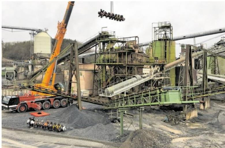
**Einbau mit Hilfe eines Schwerlastkrans: Über 100 000 Euro investiert Westkalk im Werk Kallenhardt in neue Waschwellen für die Kalksteinprodukte.** FOTO: WESTKALK
