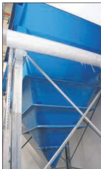
Im Schräglamellenklärer wird das Spülwasser gereinigt.
