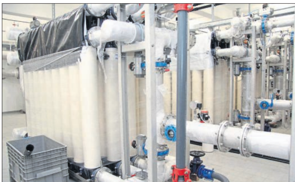
Das Herzstück der Anlage: Drei Anlagen zur sogenannten Ultrafiltration stehen im Erdgeschoss. In ihnen werden Schmutzpartikel, die sich im Wasser befinden, herausgefiltert.
