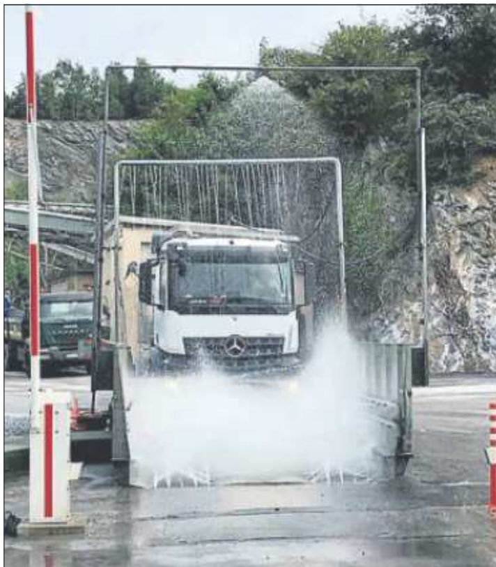
Die alte Waschanlage aus den 1980er Jahren wurde durch eine moderne, neue ersetzt. Kosten: 65 000 Euro. ■ Foto: Westkalk
