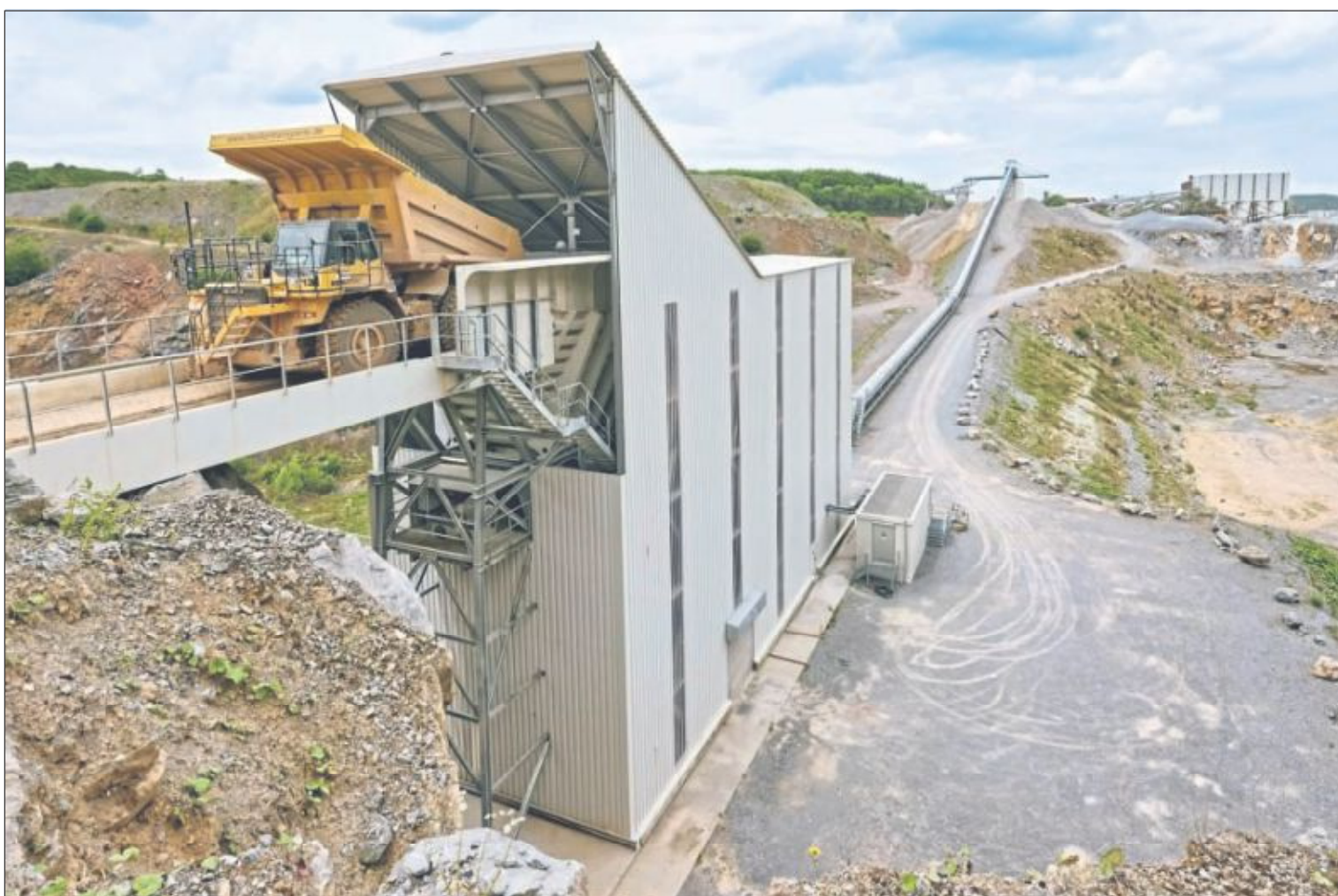
Die neue Vorbruchanlage verlängert durch die verbesserte Gesteinsausbeute die Lebensdauer des Kallenhardter Steinbruch. ■ Foto: J. Truebiger
