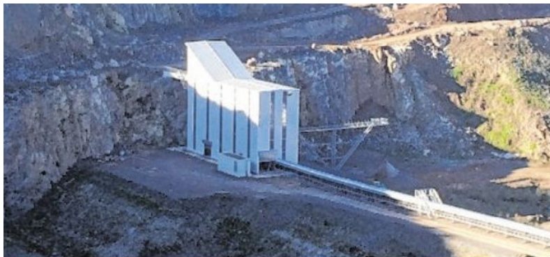
Für die neue Vorbrucharanlage mit integrierter Siebtrommel am Steinbruch in Kallenhardt investiert Westkalk 9,2 Millionen Euro.
