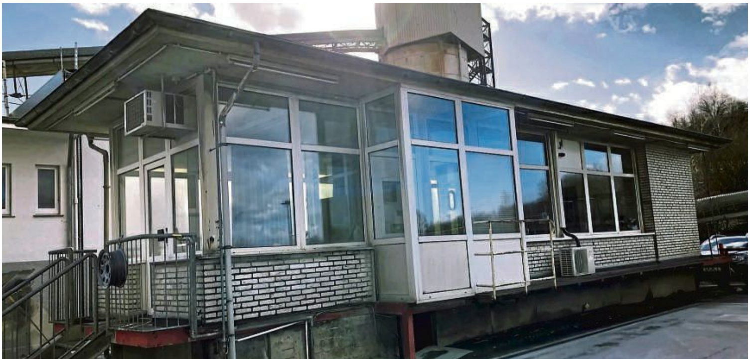
Die LKW-Waage stammte aus den 1960er Jahren. Auch hier rückt in den nächsten Tagen der Bagger an.
