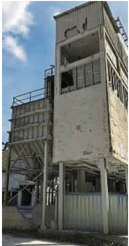
Die Abrissarbeiten gestalten sich als komplex.
